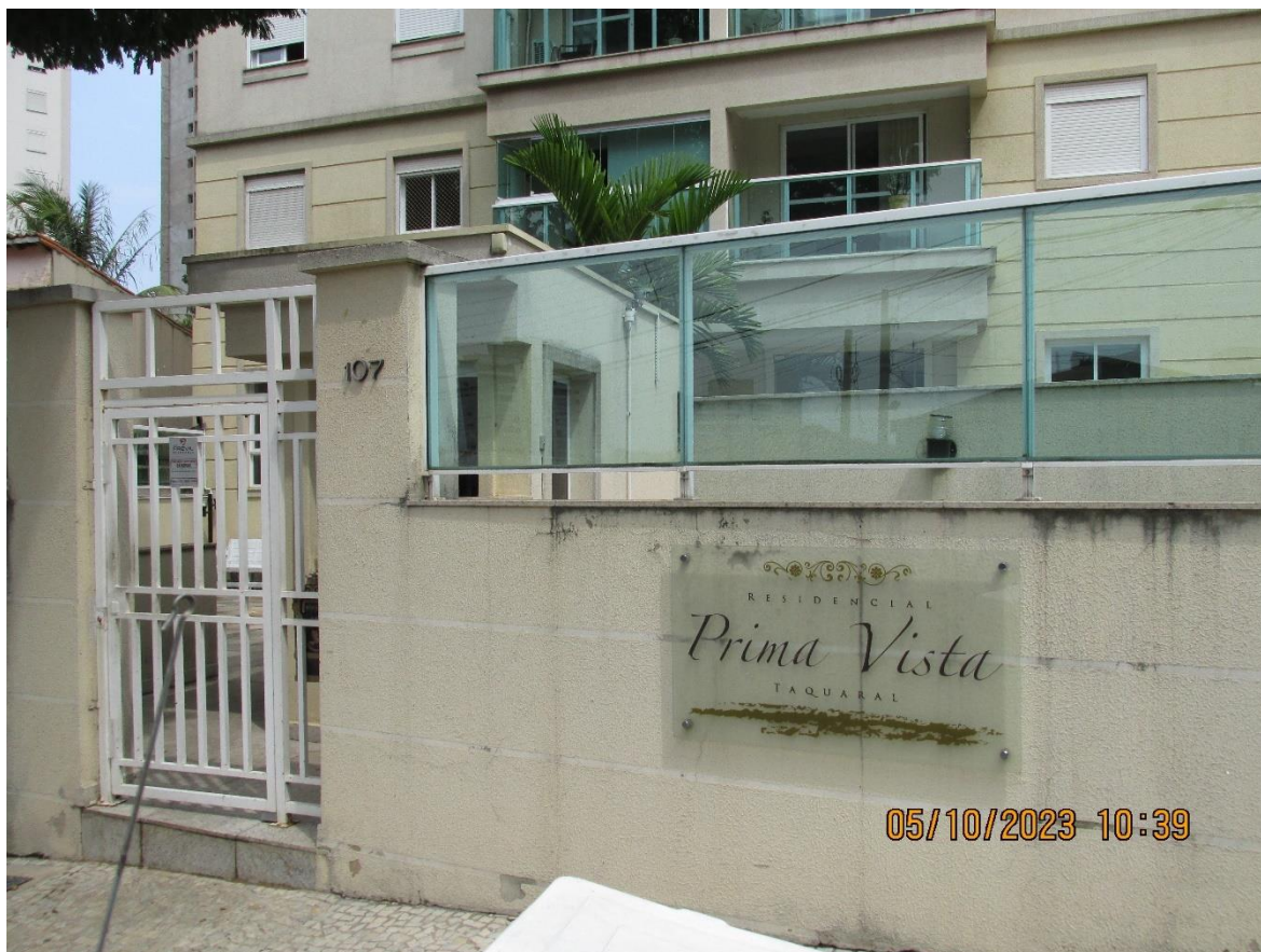
Fachada da Portaria
