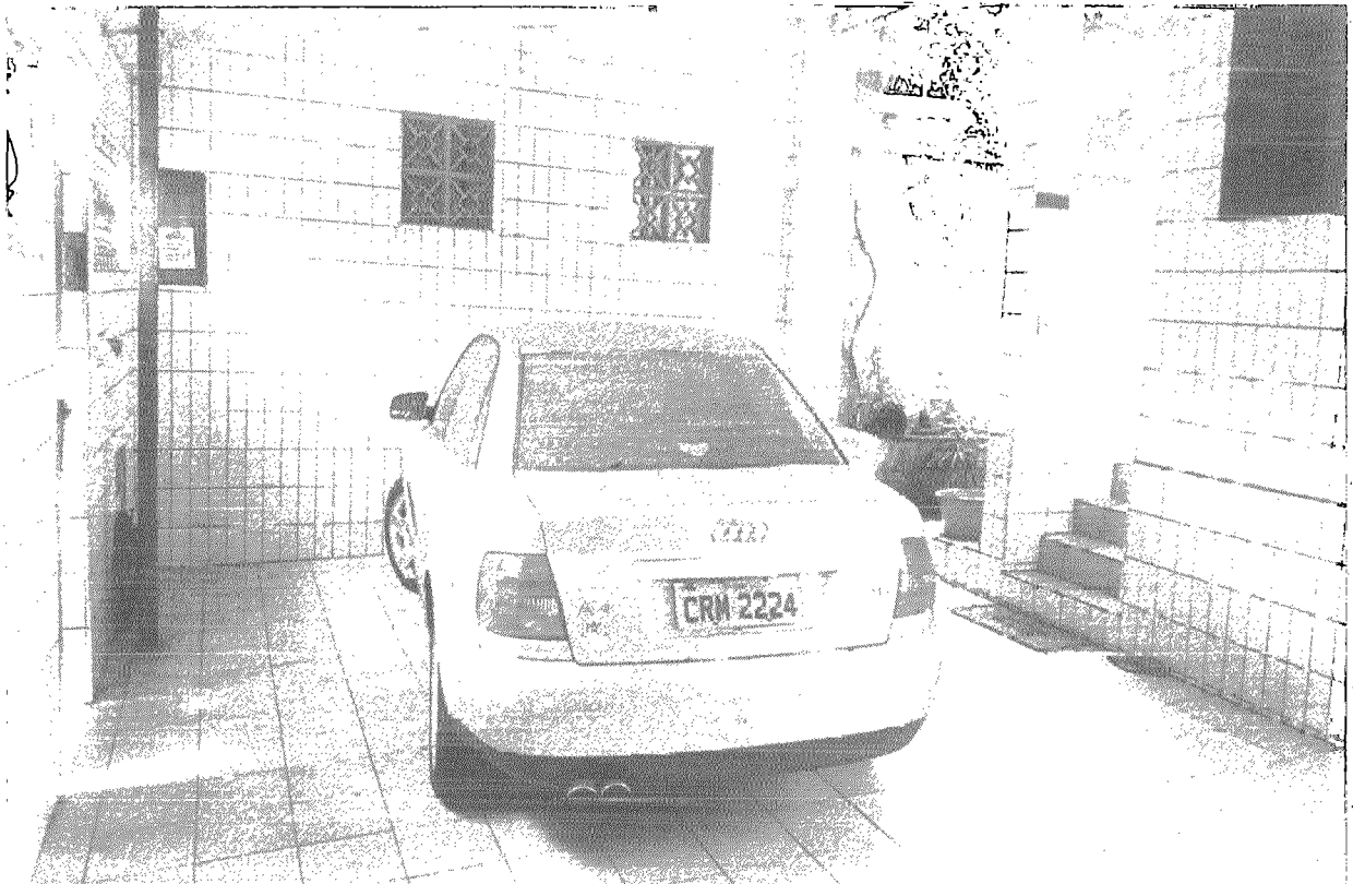
FOTO 03 - Vista parcial da área frontal de recuo coberta com vagas para automóveis .
