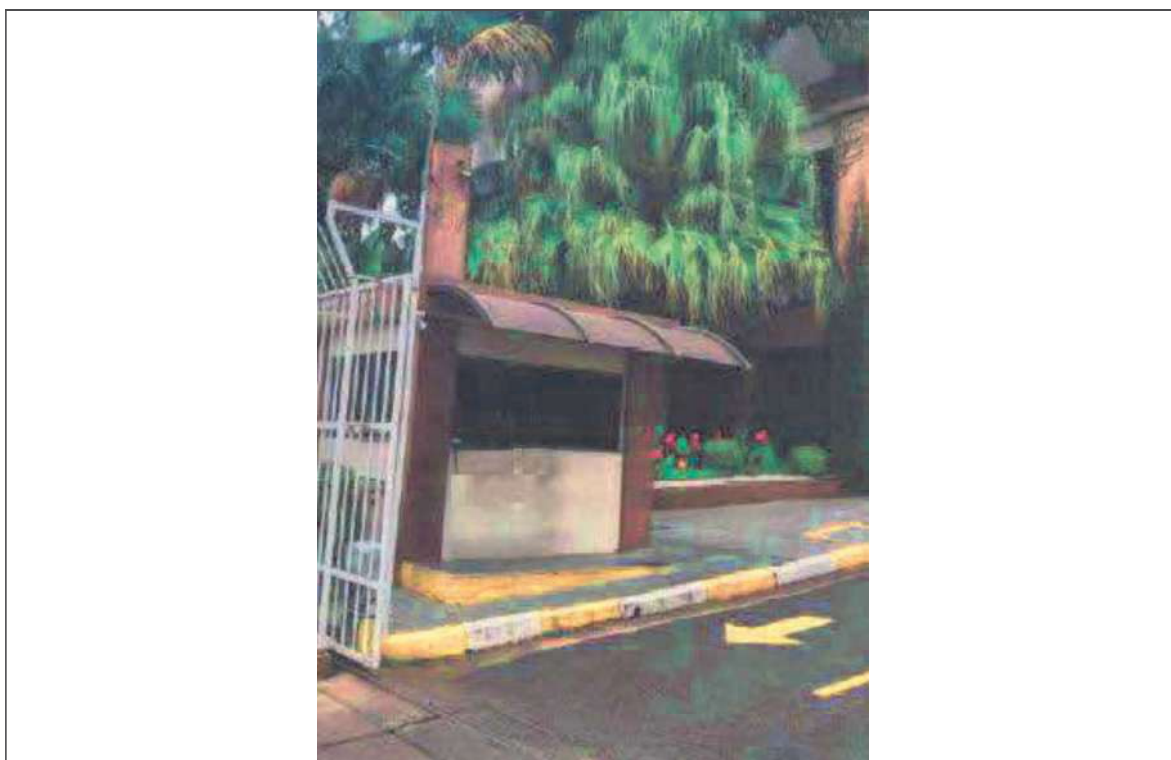
FOTO N° 11 – VISTA DA GUARITA NA ENTRADA DO CONDOMÍNIO EDIFÍCIO MIRANTE DO BUTANTÃ, DO IMÓVEL EM PAUTA.
