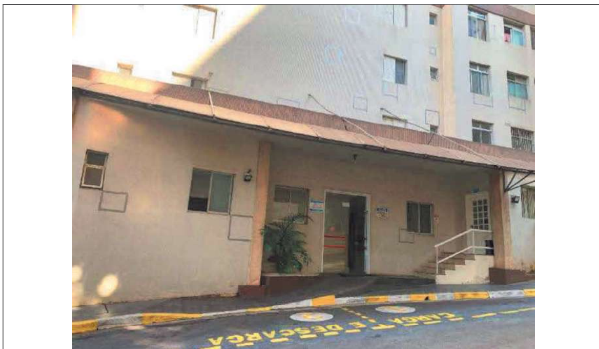
FOTO Nº 23 – ENTRADA SOCIAL DO EDIFÍCIO MIRIAM DO COMDOMÍNIO EDIFÍCIO MIRANTE DO BUTANTÃ
