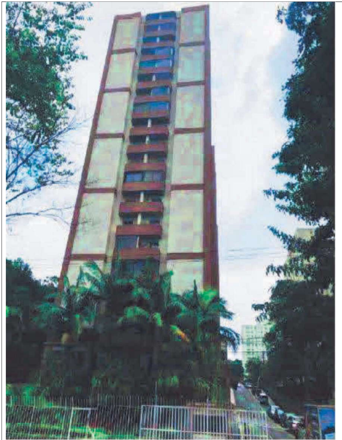
FOTO N° 12 – OUTRA VISTA DO EDIFÍCIO MIRIAM DO CONDOMÍNIO EDIFÍCIO MIRANTE DO BUTANTÃ.
