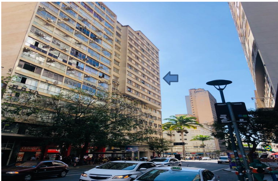
Visão da fachada do edifício
