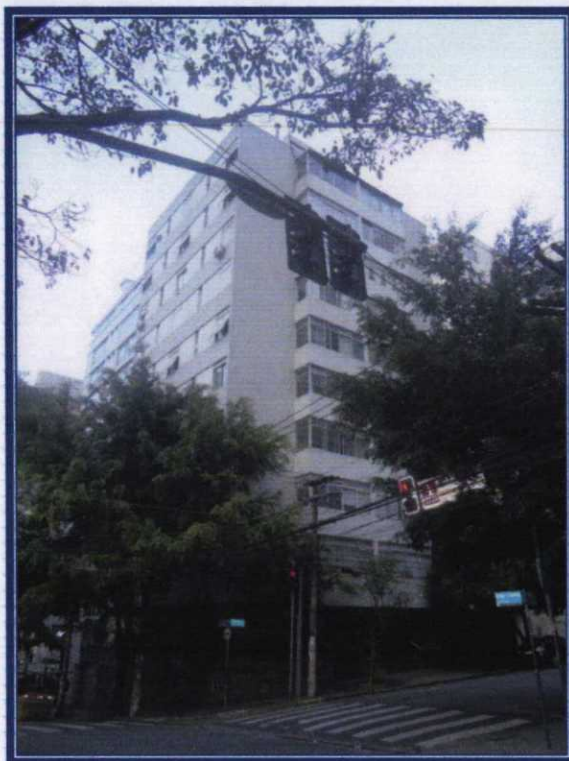
Vista geral do Edifício Triangulum.
