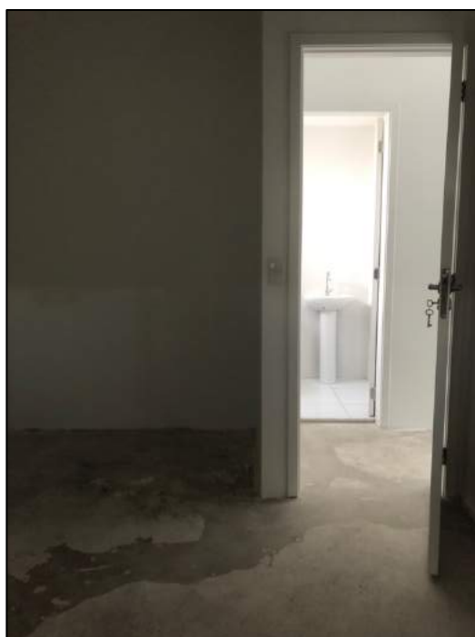
Foto 06 – Dormitório 2 e banheiro no fundo
