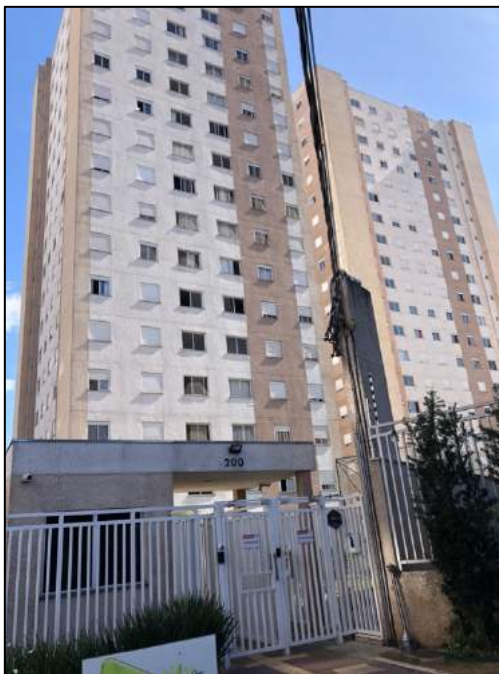
Foto 01 – Fachada/ frente do imóvel
