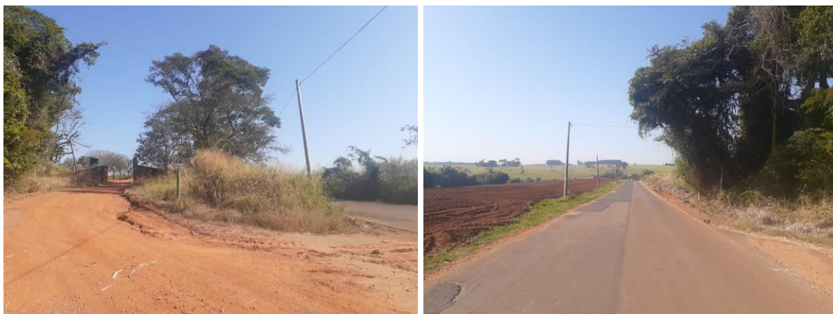
Detalhes do acesso
