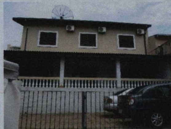
Figura 32 – Vista geral - Fundos
