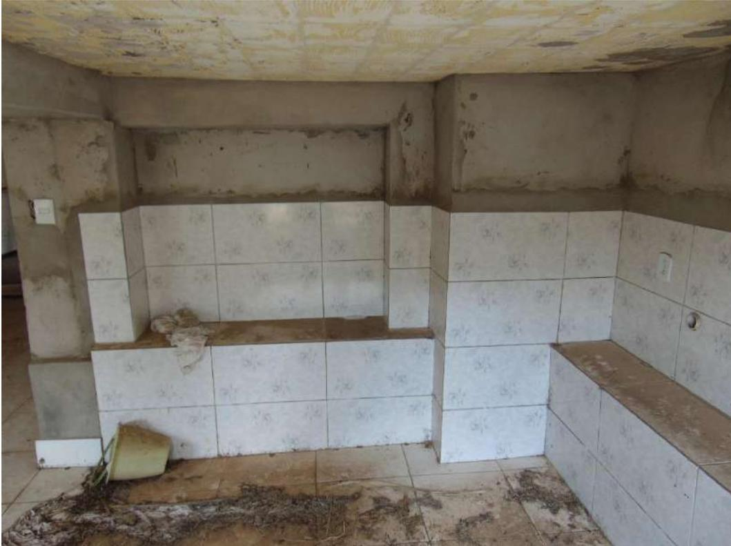
Figura 61 Identificação da sauna 1, com revestimento inacabado, e acúmulo de sujeira
