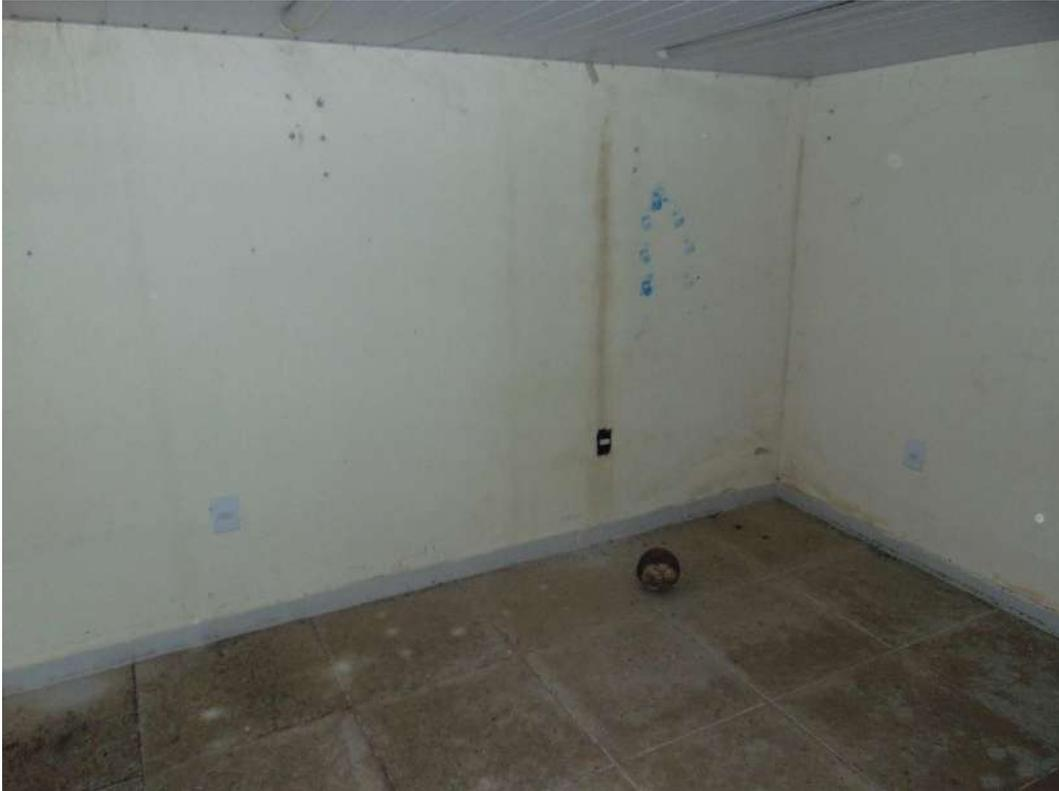
Figura 32 Identificação do closet da sala com acúmulo de sujeira no piso, e pintura com grande desgaste, forro inacabado
