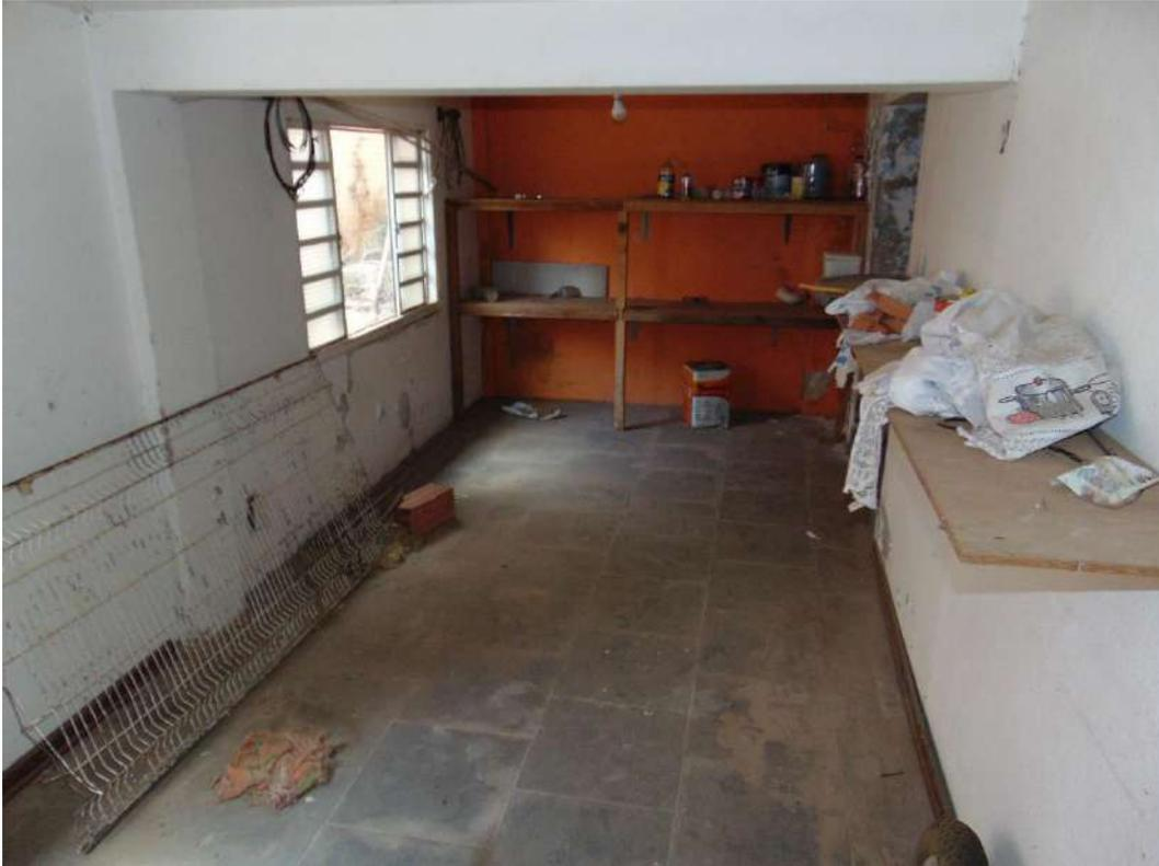
Figura 63 Oficina, pintura com desgaste acentuado, pontos de umidade, e instalações aparentes
